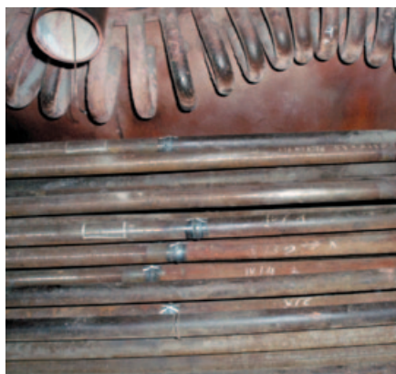
Węzownica podgrzewacza wody
